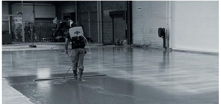
**Agilia CHAPE FORCE P4S C-1100 est une chape autonivelante fibrée à base de ciment. Ses performances sont garanties par une ATEX (Appréciation Technique d'Expérimentation) de type A délivrée par le CSTB.**
